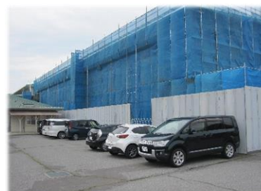
【北校舎改修工事の様子】
